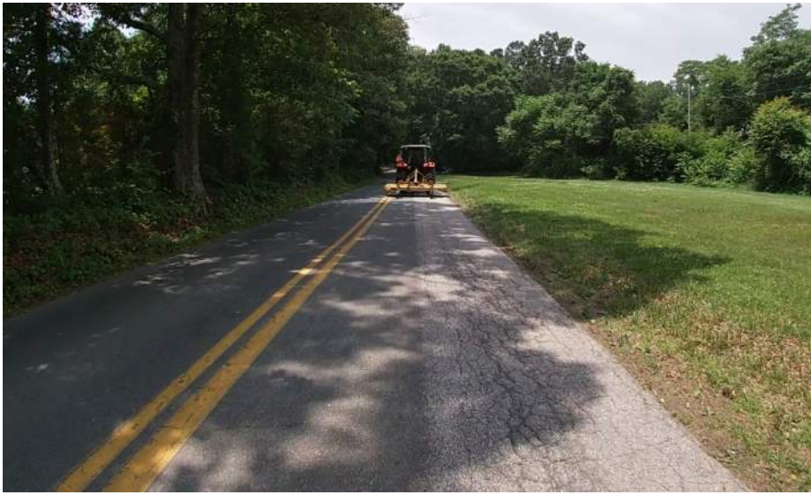
27. Alligator Cracking
